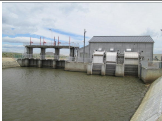
完成した大戸浜排水機場(新地町) 鉄筋コンクリート造に建屋構造を変更
