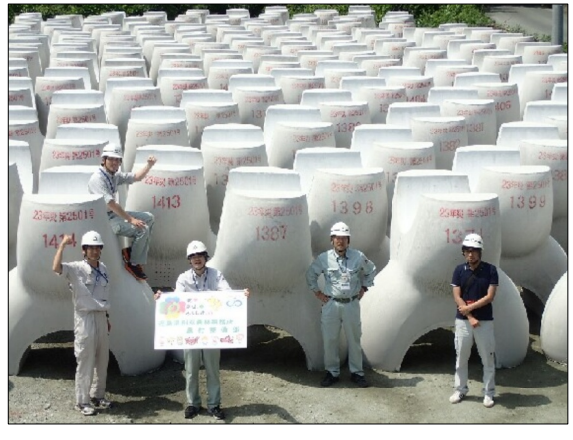
海岸災害復旧事業 消波ブロック製作ヤード(繁岡地区)
