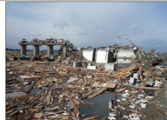
被災直後の大戸浜排水機場(新地町) 木造の建屋が流出
