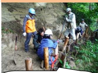
傾いた柵の内側に新たに杭を打設し、杭と杭の間に粗朶を入れて安定させました。
