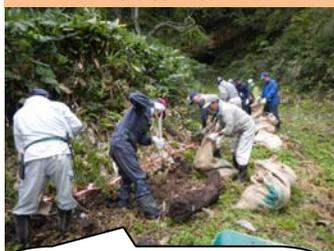
洞門入口から広場手前の既設の横断側溝まで、土側溝を掘削しました。
