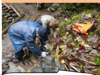
浸食防止のために設置していた黒いビニール製の土のう袋を撤去し、石積を施工しました。
