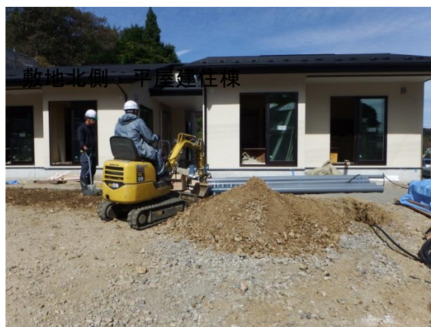
敷地北側、平屋建住棟 住宅敷地内の排水管を布設しています。
