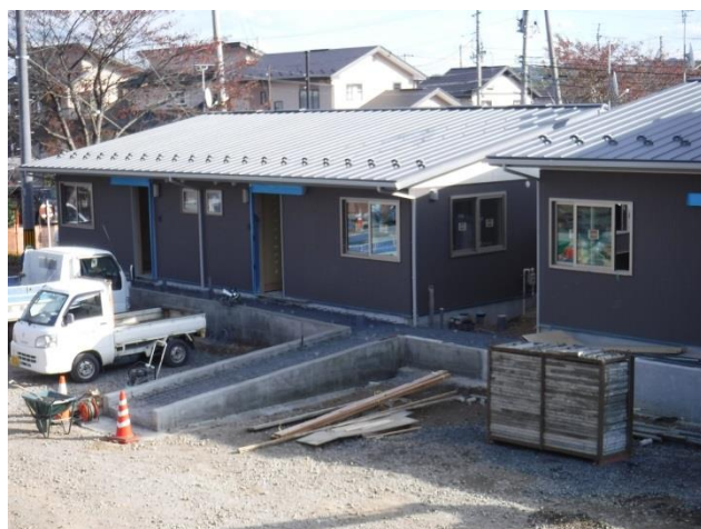
一部住棟のアプローチにはスロープを設置
