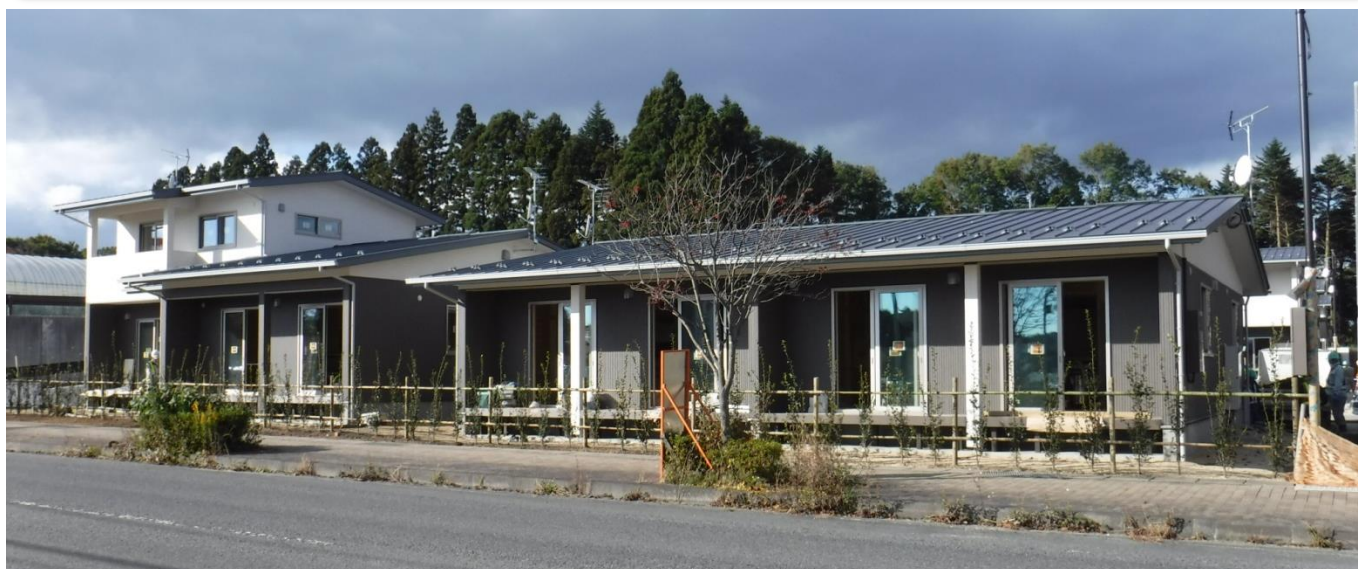
敷地南側 2階建及び平屋住棟
