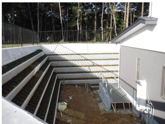
擁壁には地被類を植栽
