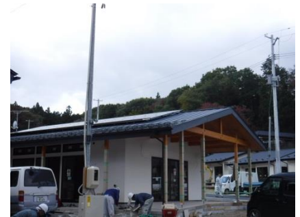
太陽光パネル設置
