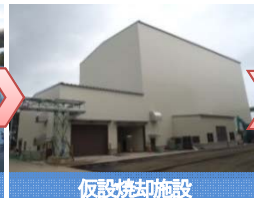
仮設焼却施設
