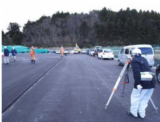
保管場舗装施工状態の確認（双葉町）
