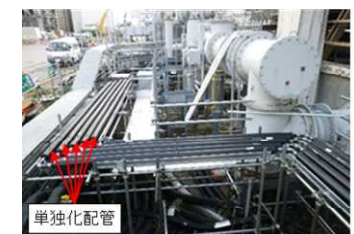
中継タンクNo.4 北側
