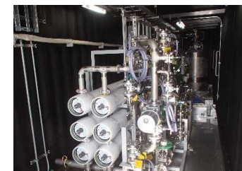
コンテナ内部の状況
