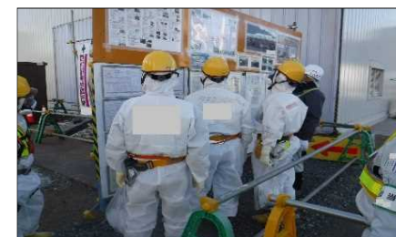
<1-6. パトロールによる不安全状態の排除>
