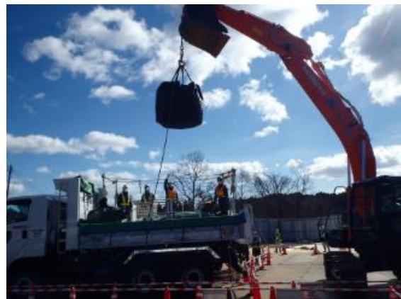
除染土壌等の積み込み確認
