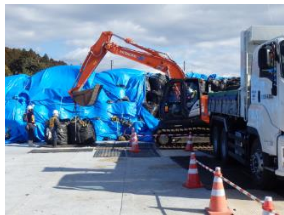
除染土壌等の積下ろし作業確認
