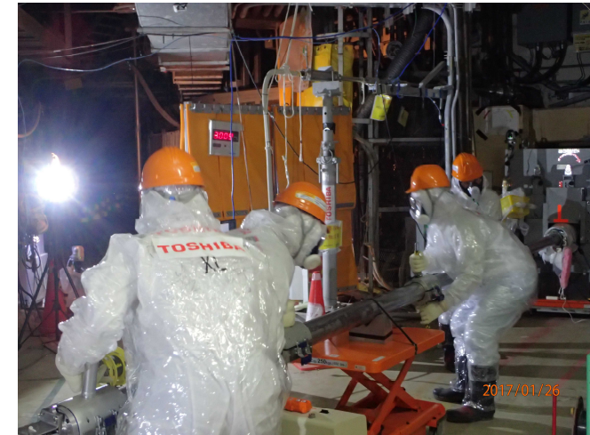
【2号機原子炉建屋内】
