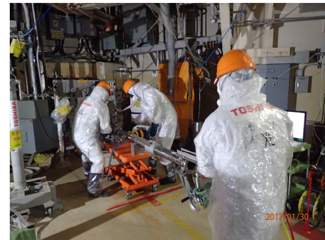
【2号機原子炉建屋内】
