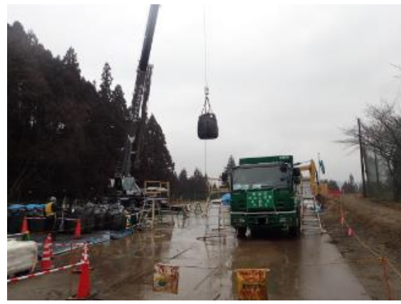
除染土壌等の積み込み確認
