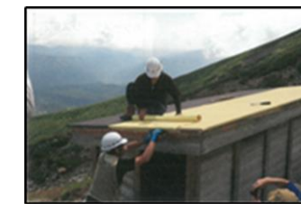
山小屋補強（アラミド繊維）
