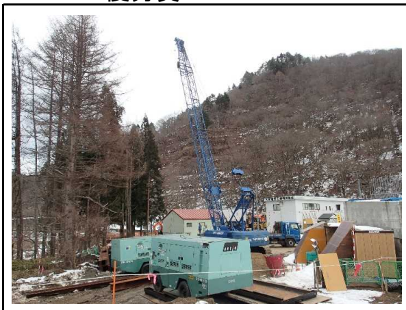
工事現場のエース
