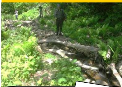
山側側溝や横断側溝を整備して排水効果を高め、路肩を丸太で土留したい。
