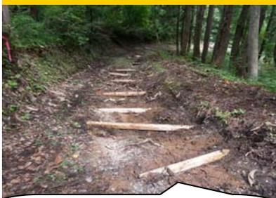
丸太を鉄筋杭で固定したり、土のう袋を充填して、車の通行が可能な状態にしたい。
