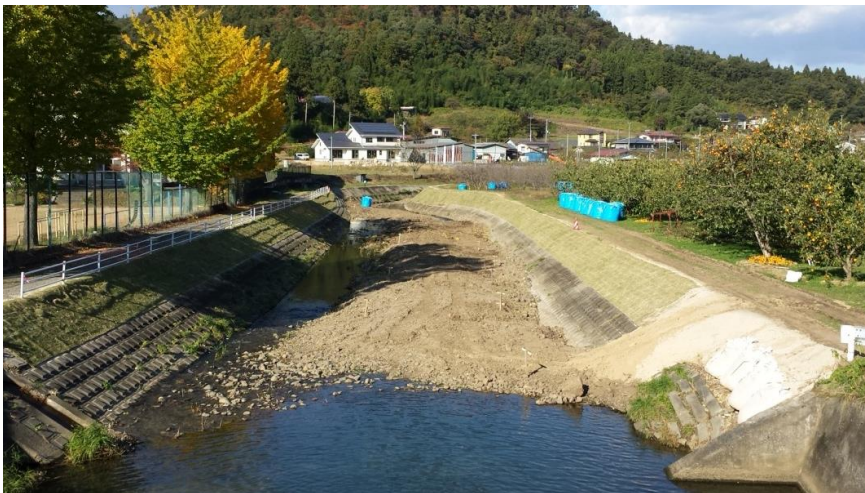
低水敷の堆積物除去後
