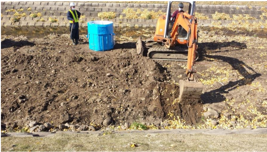
低水敷の堆積物除去
