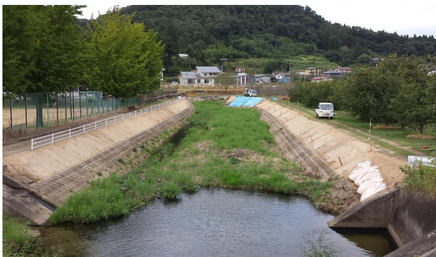
堤防敷の表土剥ぎ後
