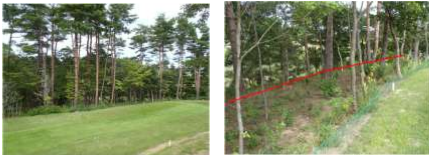
図1 施工場所写真
