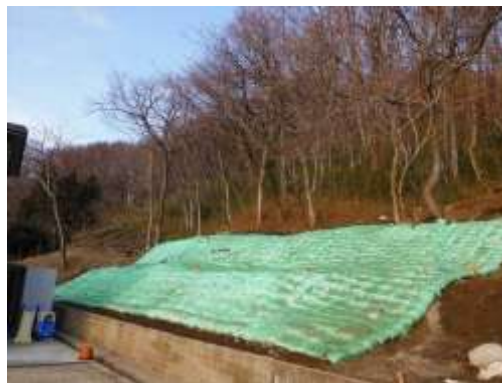
施工後の状況
