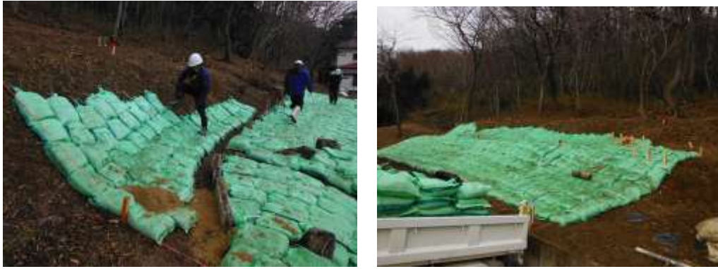
土のう敷き詰め状況
