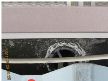
写真5：雨樋ドレイン
