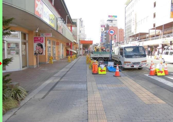
南4ブロックの車道側溝の設置を行っています。
