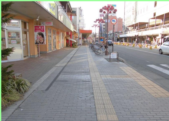
①南4ブロック工事着手前(平成29年2月1日撮影)
