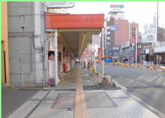
②南3ブロック工事着手前(平成29年2月28日撮影)
