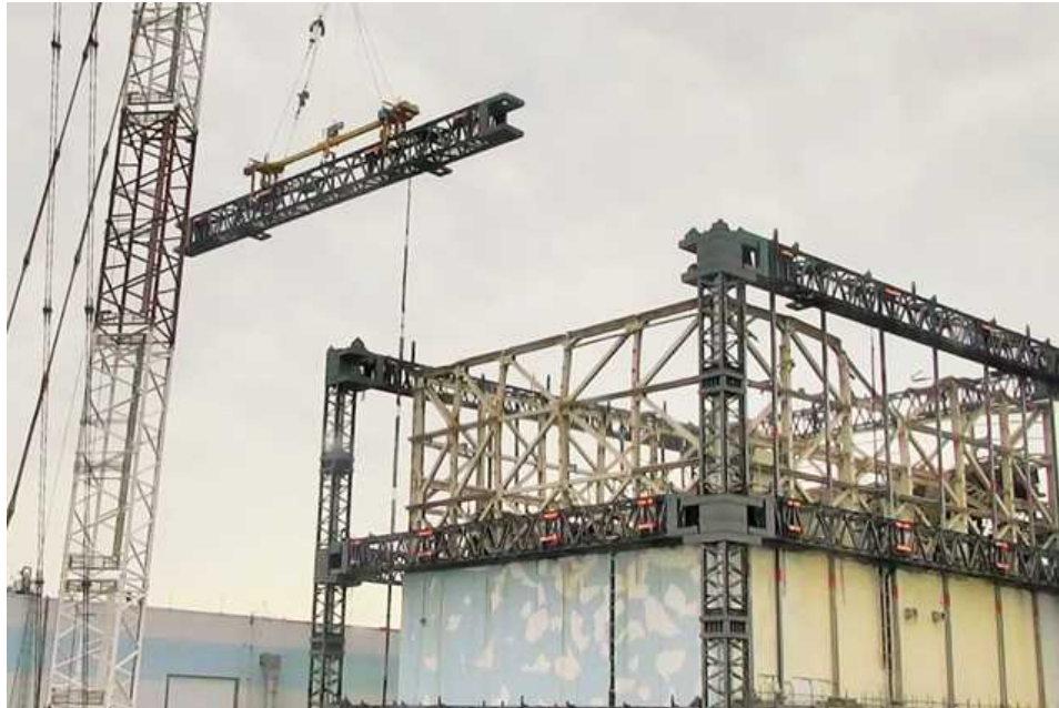
上段北梁取り外し (3/31)
