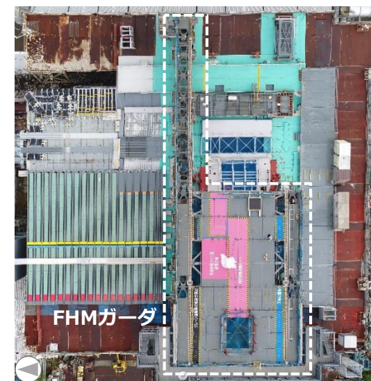
FHMガーダ設置作業中 (撮影日2017年4月21日)
