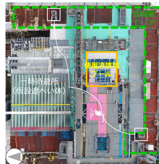
一時待避所の設置状況（撮影日2017年4月21日）
