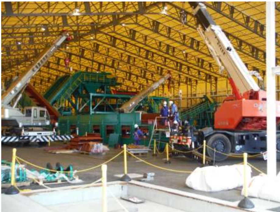
受入・分別施設予定地における工事の様子
