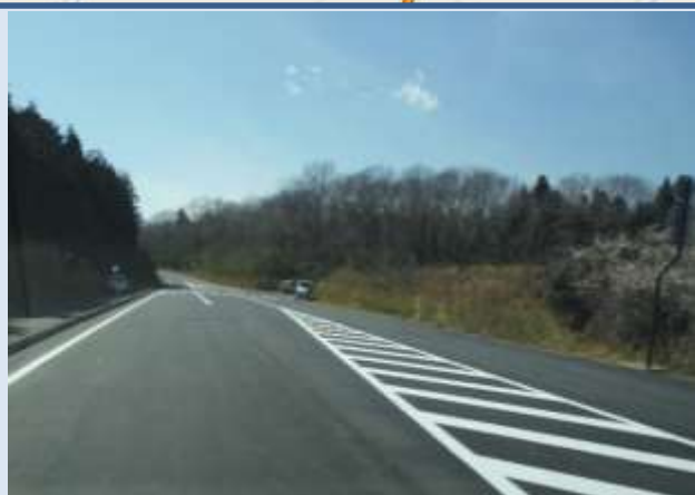
改良工事後の道路の様子(県道391号線)
