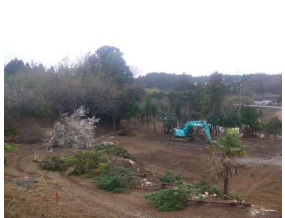
土壌貯蔵施設予定地における伐採・造成工事
