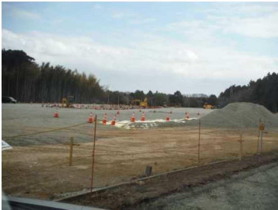
受入・分別施設予定地における造成工事
