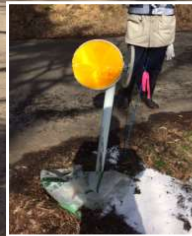
破損した反射板
