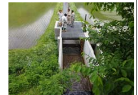
小水力発電適地調査(南会津町)
