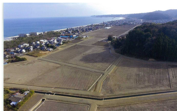
（錦・関田地区平成29年3月工事完了後）
