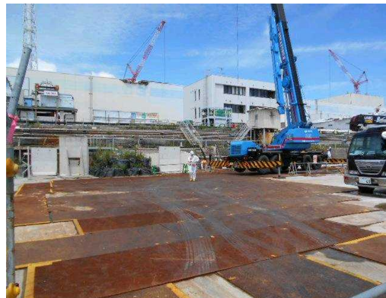
重機(クレーン)の使用
