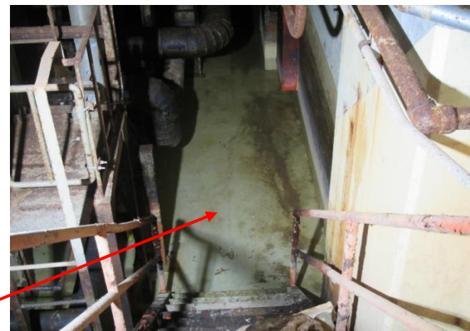
写真3 : 地下1階床面 (南側)
