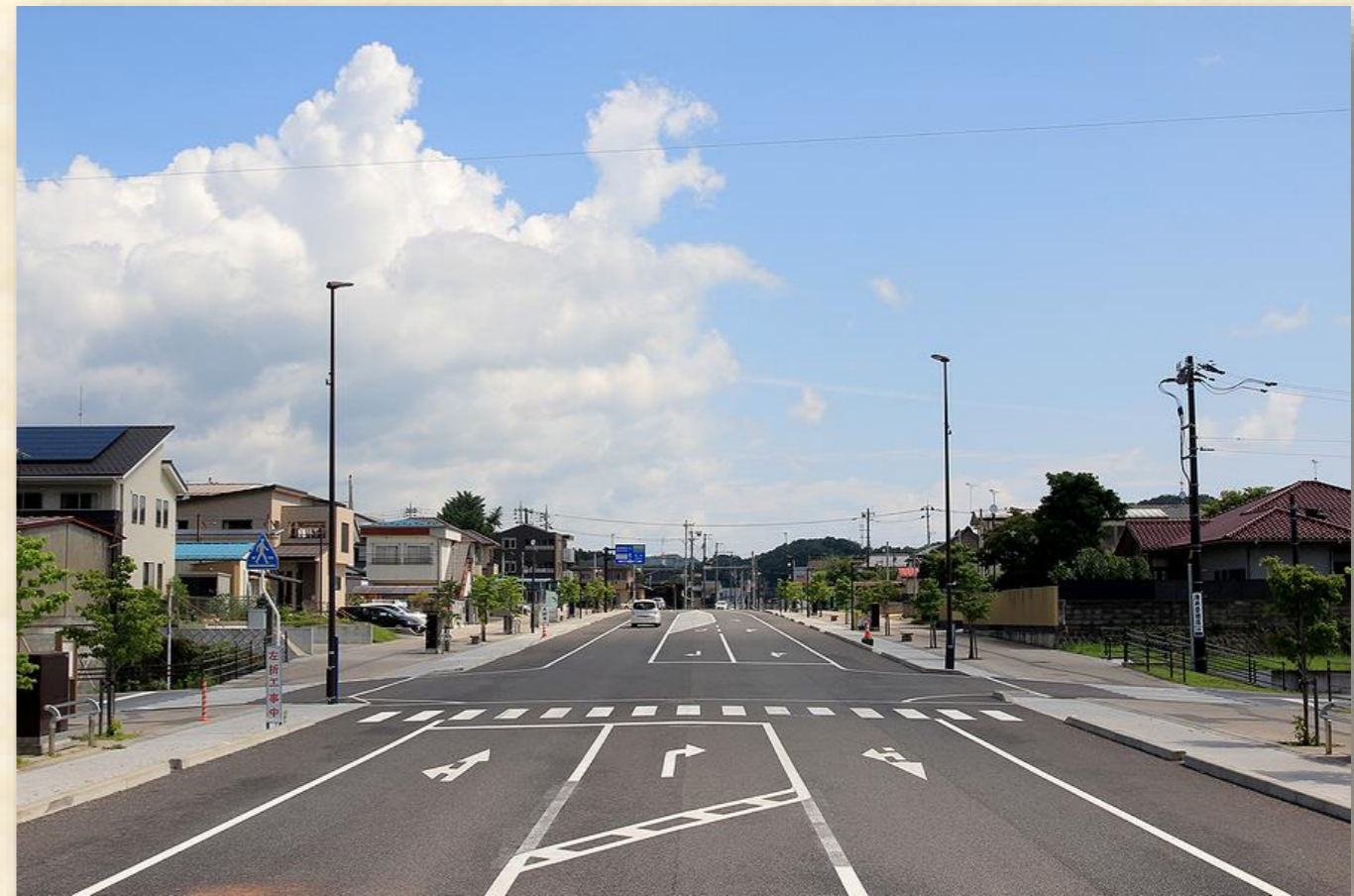
馬町工区(平成25年度供用開始)
