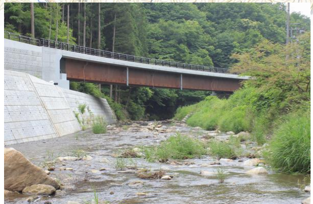
①(仮称)1号橋
