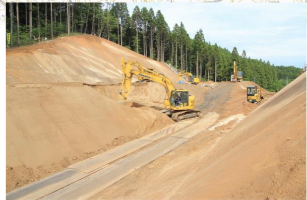
③青生野工区道路改良工事の様子
