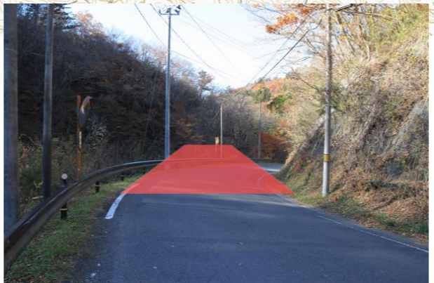
②(仮称)2号橋架橋地点
