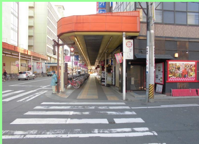
②北2ブロック工事着手前(平成29年2月28日撮影)
