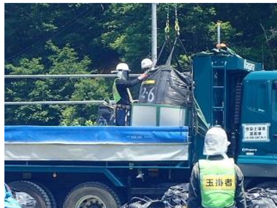
除去土壌等の積み込み作業確認
