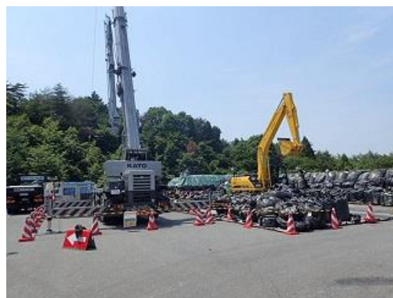
除去土壌等の積下ろし作業確認
