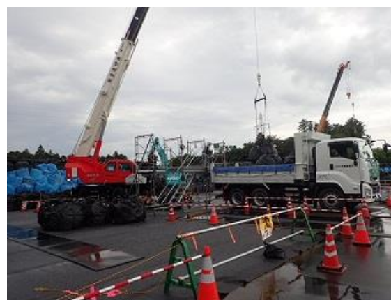
除去土壌等の積下ろし作業確認
