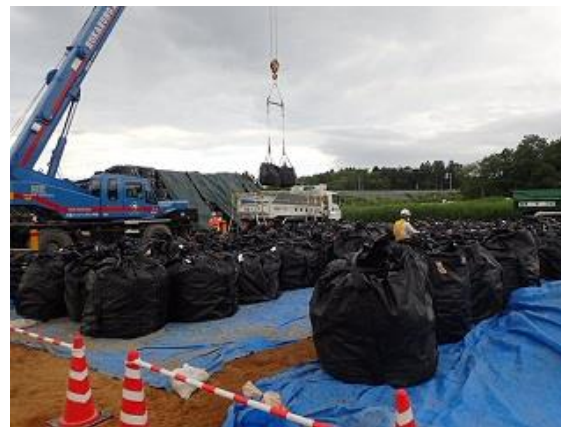
除去土壌等の積み込み作業確認
