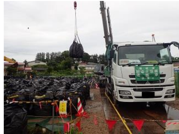
除去土壌等の積み込み作業確認
