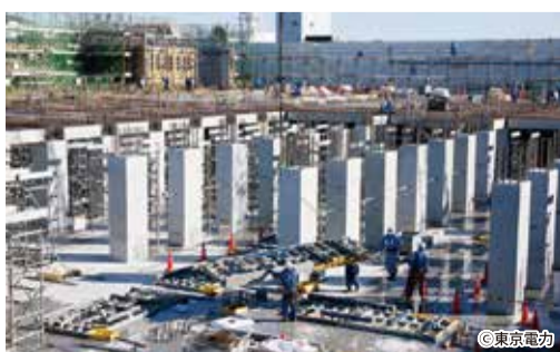
固体廃棄物貯蔵庫建設工事 地震、津波、水素爆発により発生したガレキを保管する施設を建設中です。
