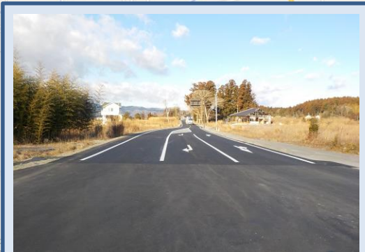
改良工事後の道路の様子(県道251号線)
