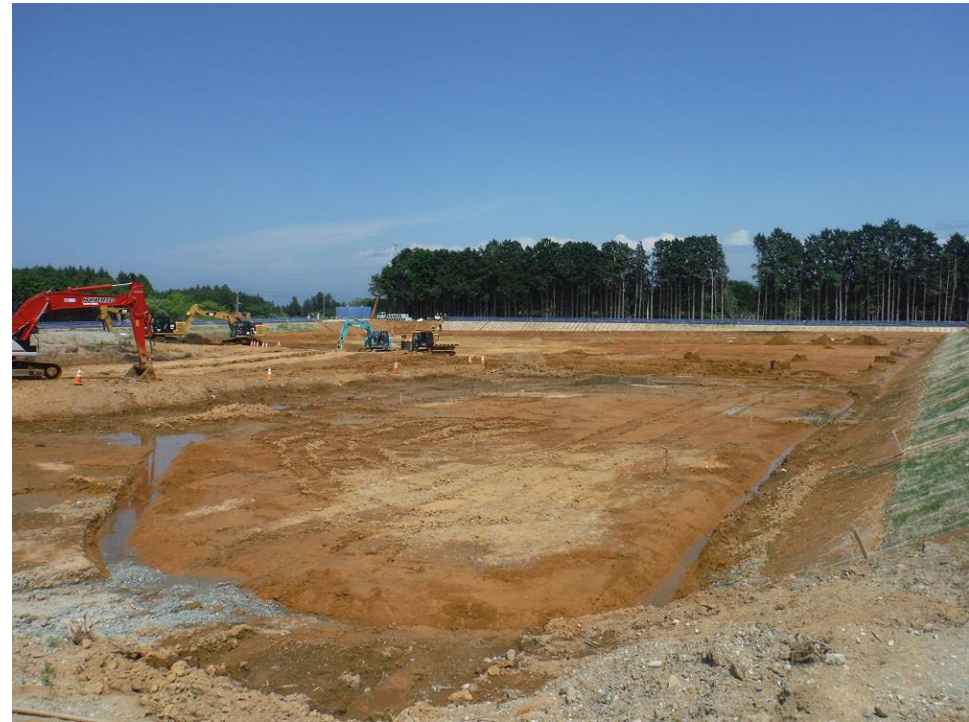
土壌貯蔵施設予定地における造成工事
