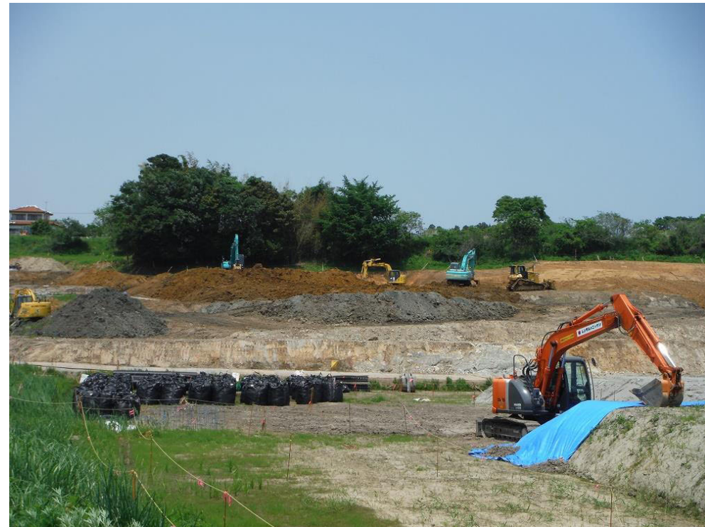
土壌貯蔵施設予定地における伐採・造成工事
