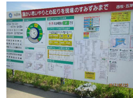
施工体制他安全表示確認
