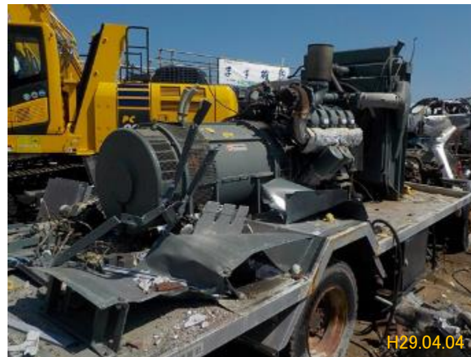
電源車解体状況
