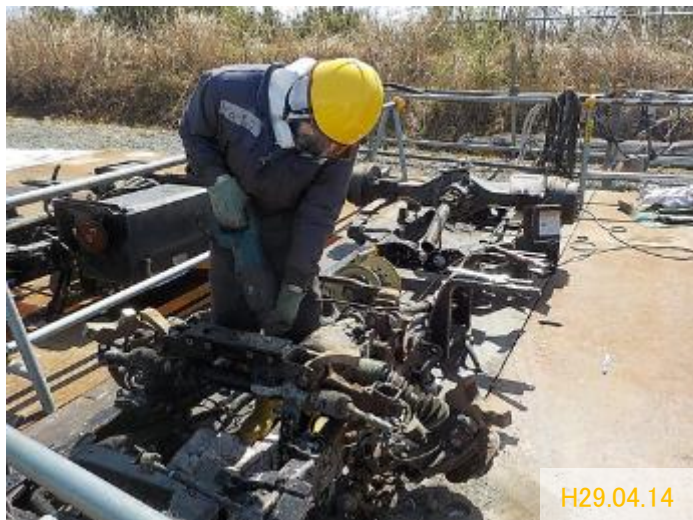
電源車解体状況
