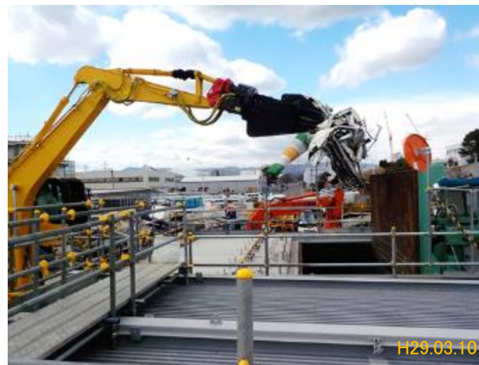
車輻投入状況
