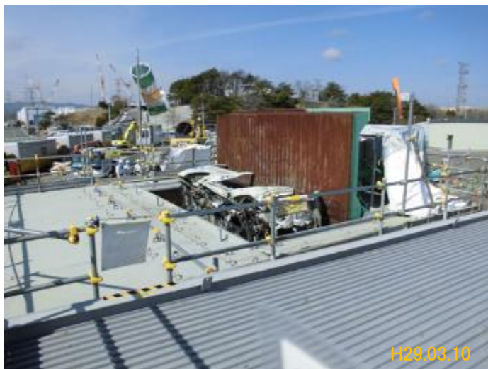
車輻投入状況
