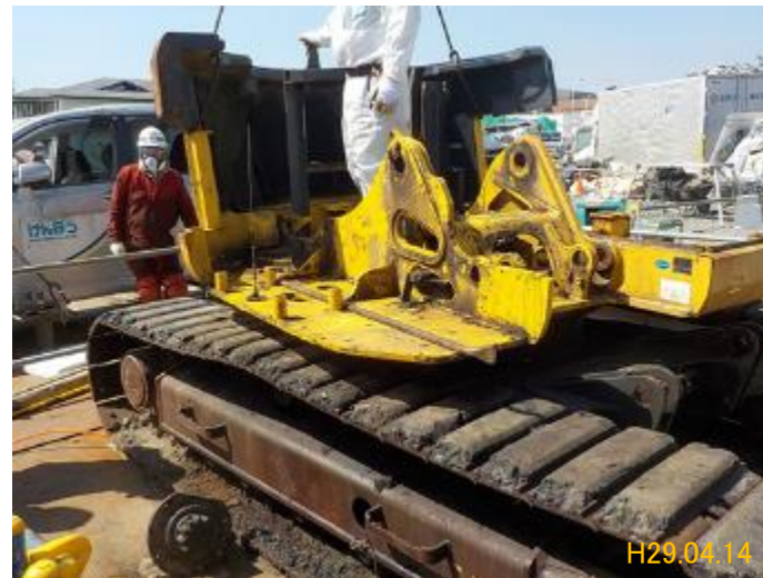
バックホー解体状況
