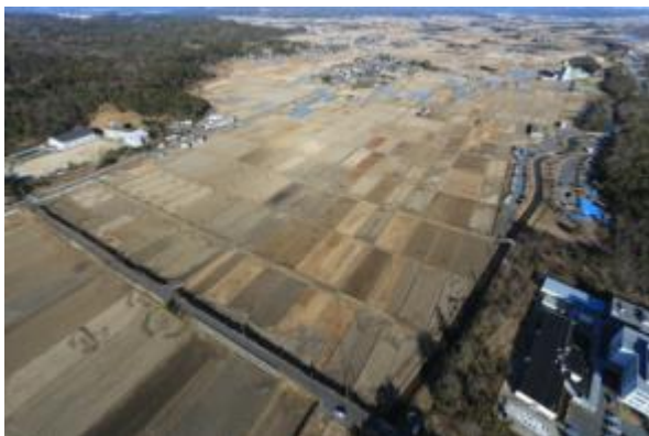
（H27.1 夏井地区整備前）
