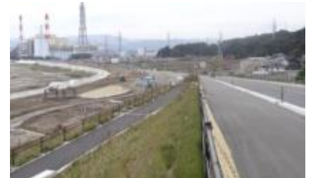
岩間地区の復旧状況 海岸堤防内側に防災緑地の工事中 （左上は常磐共同火力発電所）
