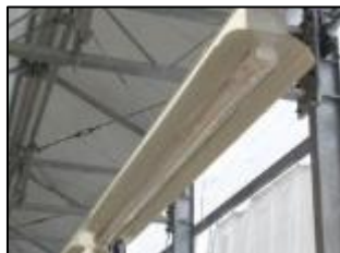
蛍光灯へカバー設置 →飛散防止し、異物混入を予防
