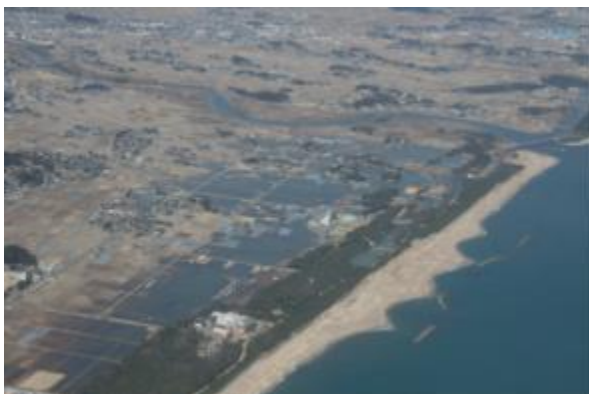
(夏井地区津波による湛水状況)
