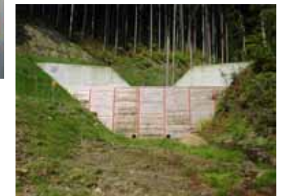
治山ダム（矢祭町 入山地区）
