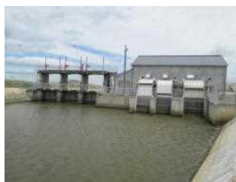
排水機場の復旧状況
