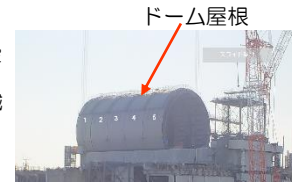
<1-29. ドーム屋根設置状況>
