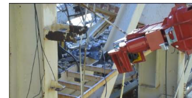
<1-15. カッターによる切断の状況(オペレーティングフロア調査における支障物撤去作業時)>
