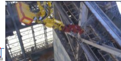
<1-15. カッターによる切断の状況(オペレーティングフロア調査における支障物撤去作業時)>
