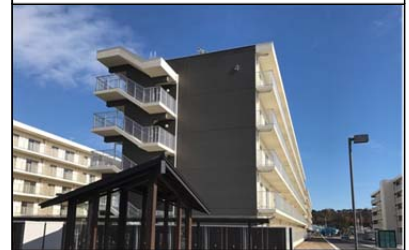
復興公営住宅（南相馬市）
