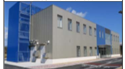
廃炉国際共同センター 国際共同研究棟
