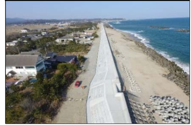
仁井田地区海岸堤防（完成 H29.3）
