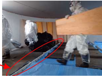
<4-10. 作業方法及び現場の状況場所>
