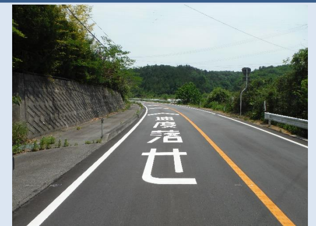
改良工事後の道路の様子(国道288号線)
