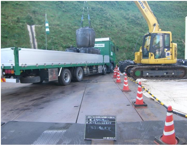
積込作業(伊達市)
