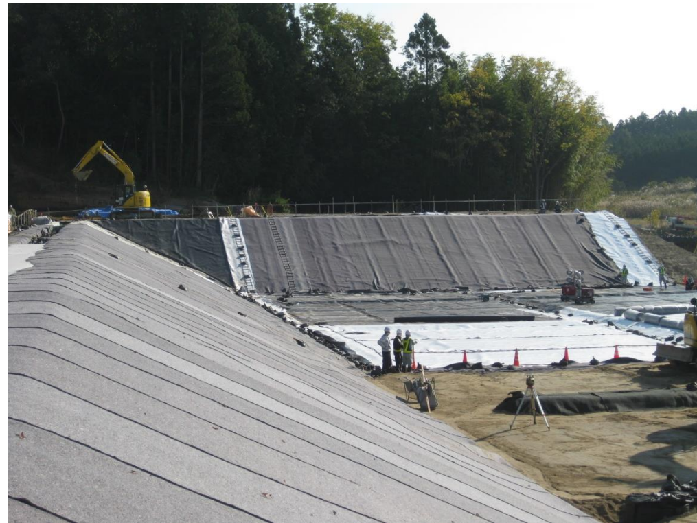
土壌貯蔵施設予定地
