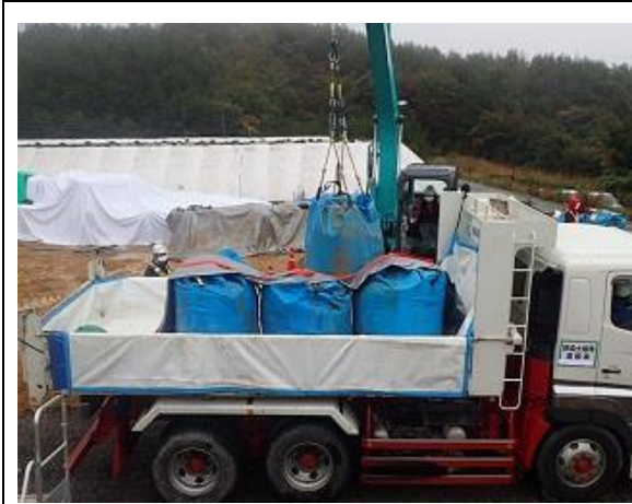
除去土壌等の積み込み作業確認 1
