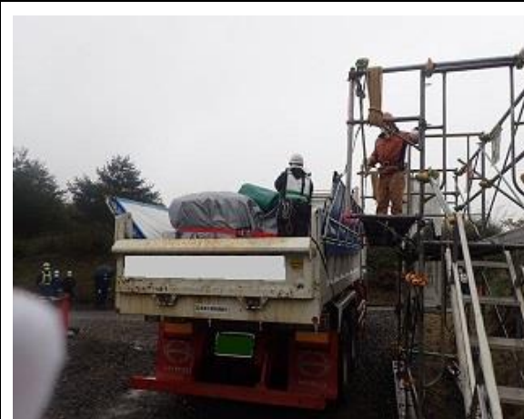
除去土壌等の積み込み作業確認 2
