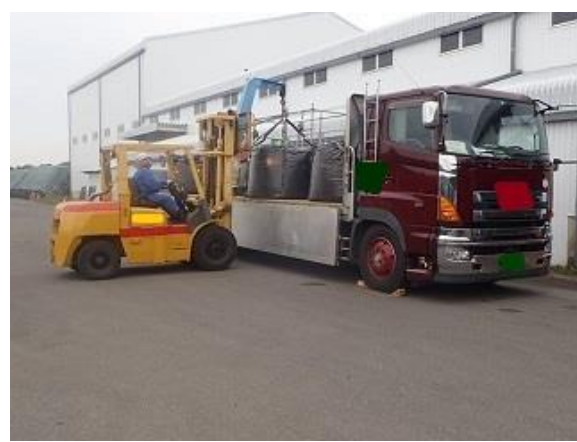
除去土壌等の積下ろし作業確認
