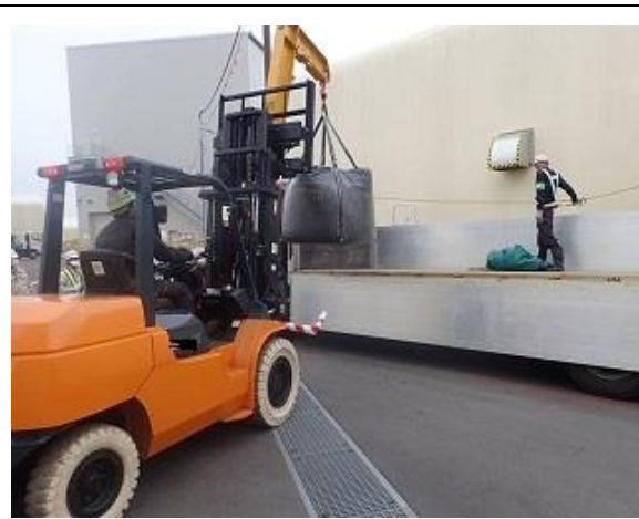
除去土壌等の積み込み作業確認
