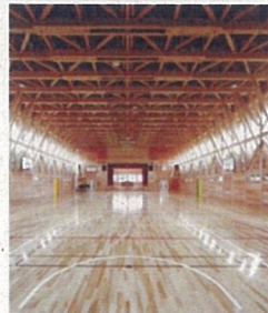
耐震的100年程度の耐震耐震で大空間を構成 喜多方市立熊倉小学校体育館、耐震中野耐震設計、 耐震設計者 北川建設事務所
