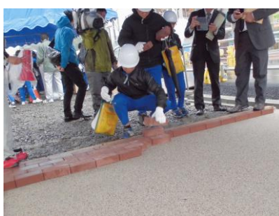
ブロック設置
