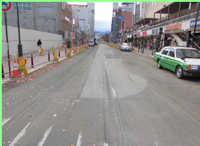
①車道工事施工中(平成29年12月1日撮影)
