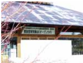
オープンラボの外観
