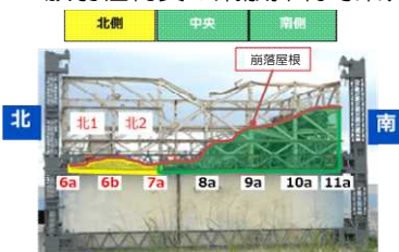
北側瓦礫撤去範囲（今回） 中央・南側瓦礫撤去範囲（今後計画）
