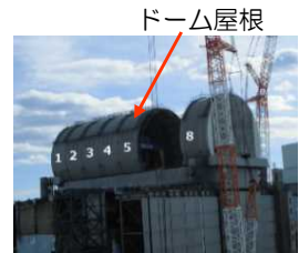
<1-26. ドーム屋根設置状況>
