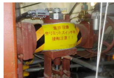
<4-5. 注意喚起表示取付け状況>
