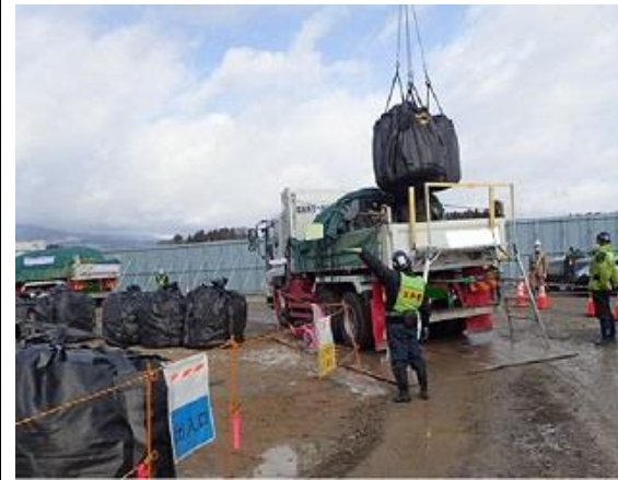
除去土壌等の積み込み作業確認
